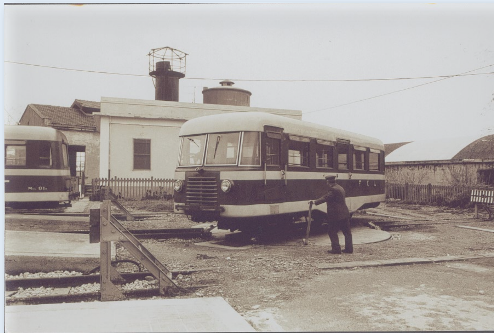
Foto ASSMCL - Catanzaro Lido – Emmina in manovra
