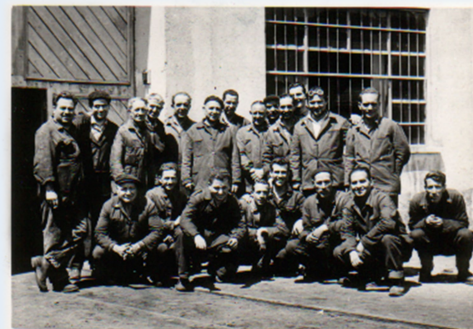
Foto ASSMCL - anni '50 - Ferrovieri in posa - deposito di Cosenza
